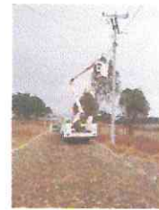
Imagen 1. Rehabilitación de alumbrado público Fuente: elaboración propia (2025)
