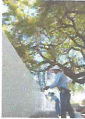
Imagen 9. Mantenimiento de pintura en parque "Cura Correa" Fuente: elaboración propia (2025)
