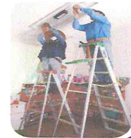
Imagen 4. Renovación de sistema eléctrico preescolar de la comunidad de El Jagüey Fuente: elaboración propia (2025)
